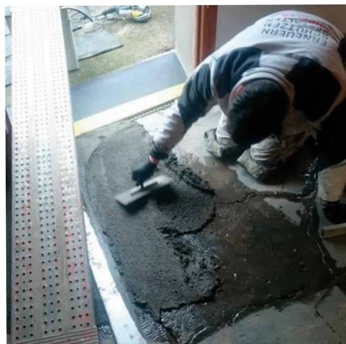
Im Eingangsbereich mußte der Boden um 2 cm wegen starker Unebenheit angeglichen werden. Außerdem wurde eine Schieferplatte im Eingang verlegt.
